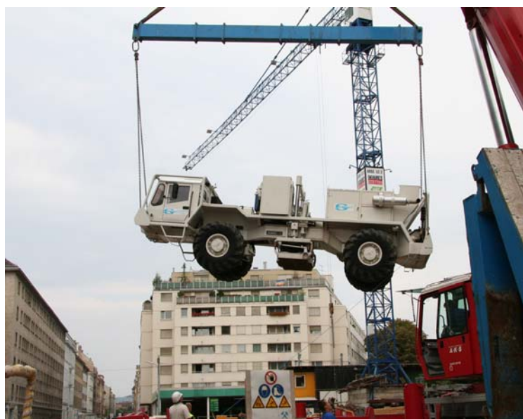
Abb.3: Hochleistungs-Schwingungsgenerator beim Einhub in einen Wiener U-Bahn-Bauschacht
